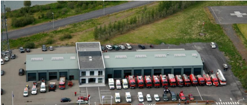
Aðalslökkvistöð á Selfossi (Bygging hússins hófst 2005, lauk 2011)
