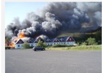
Eitt þekktasta hús landsins, Valhöll á Þingvöllum brann 10. júlí árið 2009. Húsið var gamalt timburhús, þar voru eldvarnir af skornum skammti.
